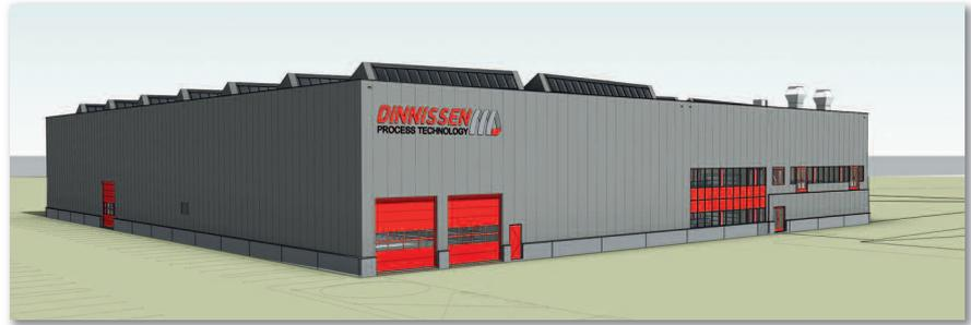
Realisierung einer zusätzlichen, 4.200 m<sup>2</sup> großen Produktionshalle. Diese wird direkt an die bestehenden Gebäude von Dinnissen angrenzen. Sie wird über zehn Tonnen Brückenkräne und Wandkräne verfügen, sowie Laserschneideanlagen, sehr präzise Dreh-, Fräs- und Kantmaschinen, eine separate RVS Schweißhalle und einiges mehr, um auch in Zukunft al-
