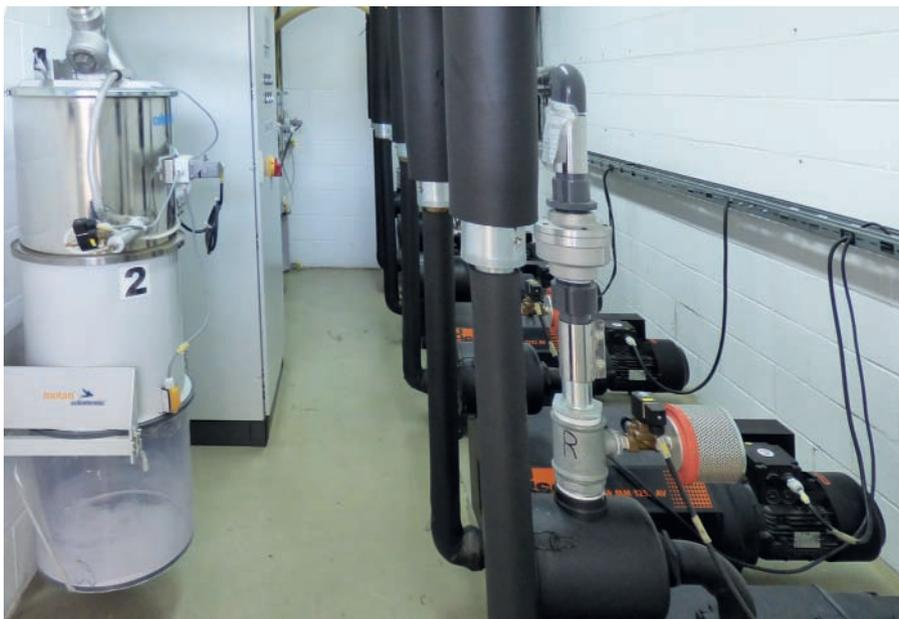
Die insgesamt fünf Vakuumpumpen, der Materialversorgung, zwei davon als Standby-Reserve sowie der Sicherheitsfilter (links) befinden sich im Stockwerk oberhalb des Reinraums in einem separaten, abgesicherten Raum
