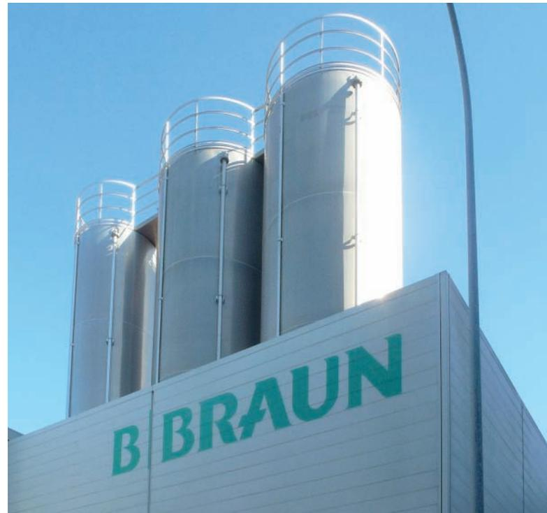
Von den drei Außensilos wird das Granulat zur Produktion über Zweikomponentenweichen und eine Siloumschaltung in Zwischenbehälter gefördert
