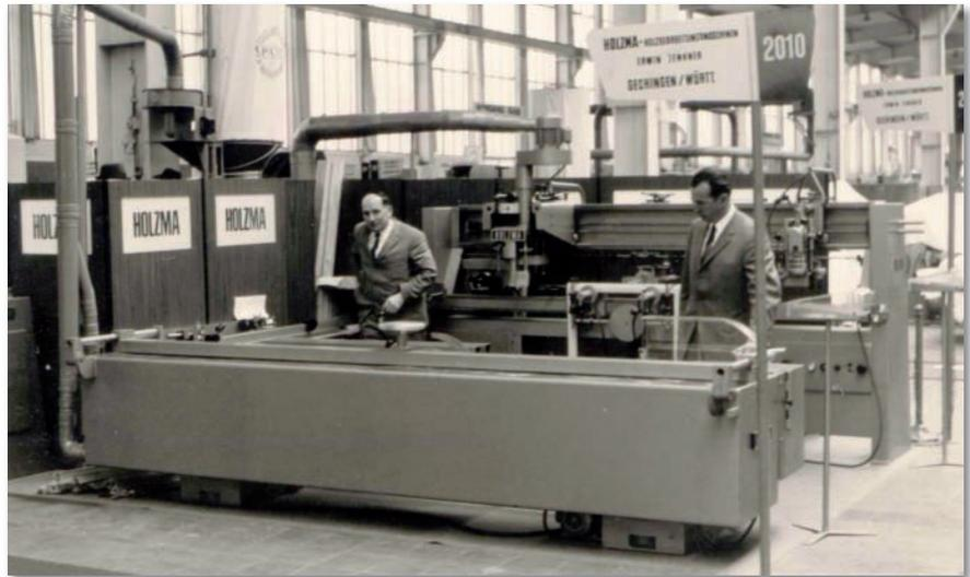
*Erste Plattenaufteilsäge, ausgestellt auf der LIGNA 1967. Noch ohne Druckbalken*
