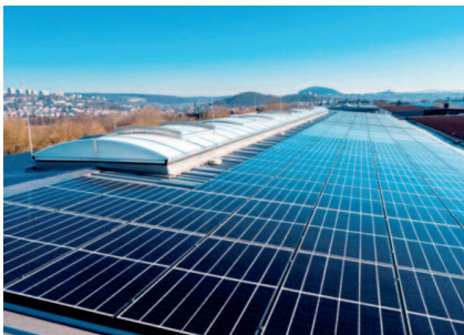
PV-Module auf einer Fläche von insgesamt 550 m 2 bringen eine Leistung von 100 Kilowatt-Peak (kWp)
