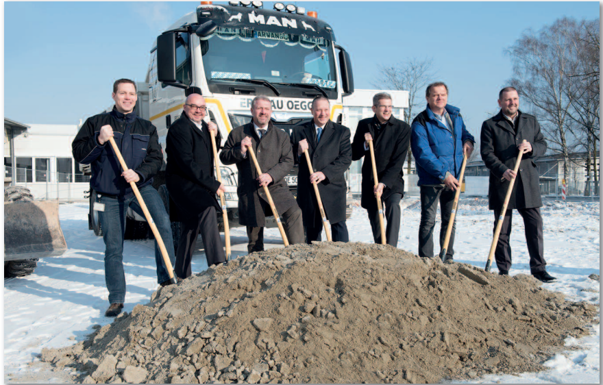
Spatenstich für das Bildungszentrum der KIEFEL GmbH, von links: Stefan Stachelscheid (Facility Manager, Kiefel), Dr. Bernd Stein (COO, Kiefel), Josef Flatscher (Bürgermeister der Stadt Freilassing), Thomas J. Halletz (CEO, Kiefel), Peter Eisl (CFO, Kiefel), Roland Richter (Architekt), Helmut Strecha (Produktionsleiter, Kiefel)
