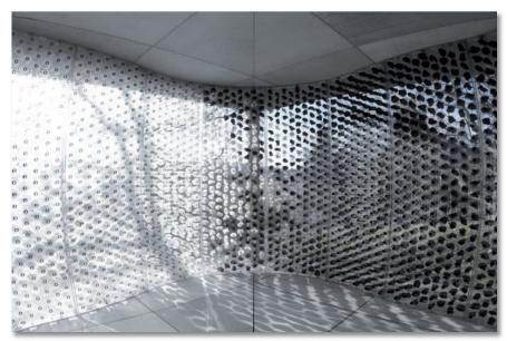
Die rechtlich geschützte Entwicklung von Tobias Becker ermöglicht es, die Durchlässigkeit von Fassaden stufenlos zu variieren. Sie basiert auf der Idee, einen Innenraum über porenartige Luftkanäle ohne das Auftreten eines Luftzugs ganzflächig zu belüften. Durch pneumatische "Muskeln" kann ihre Durchlässigkeit für Luft, aber auch für Blicke und Licht individuell gesteuert werden
