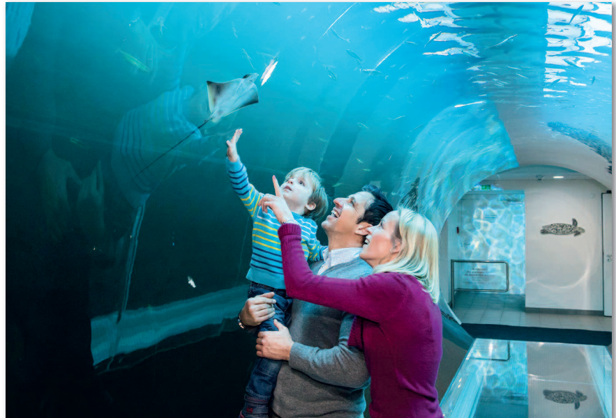
Tunnel-Aquarium hergestellt aus PLEXIGLAS®. k-tec produzierte das mit Abstand größte horizontal eingebaute monolithische Rohr aus PLEXIGLAS®: rund 10 m Länge, 3 m Durchmesser, 120 mm Wandstärke und 15 Tonnen Gewicht. Thilo Üblagger von k-tec in Radstadt referiert unter anderen bei der Veranstaltung (Bild: k-tec/Daniel Zupanc)
